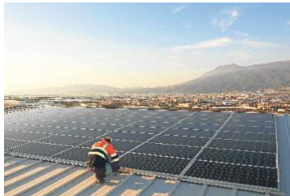
ÚLTIMOS TRABAJOS de instalación de placas en la cubierta de Hotofrutícola Las Norias.
