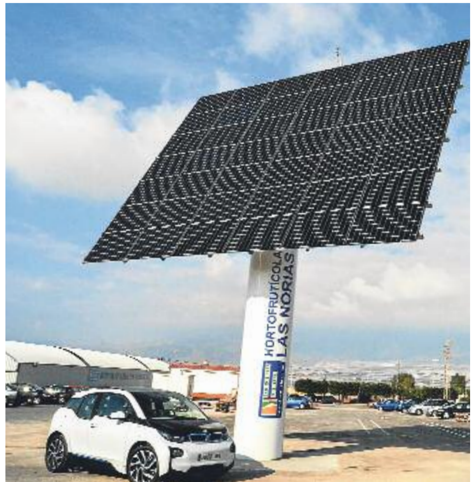
TORRE INSTALADA en Hortofrutícola Las Norias. Junto al pie, una unidad eléctrica de BMW i3. Sun Tower está programada para buscar la mejor orientación solar y para adoptar una posición paralela al viento en el caso de que supere los 80 km/h. J.CASTILLO
